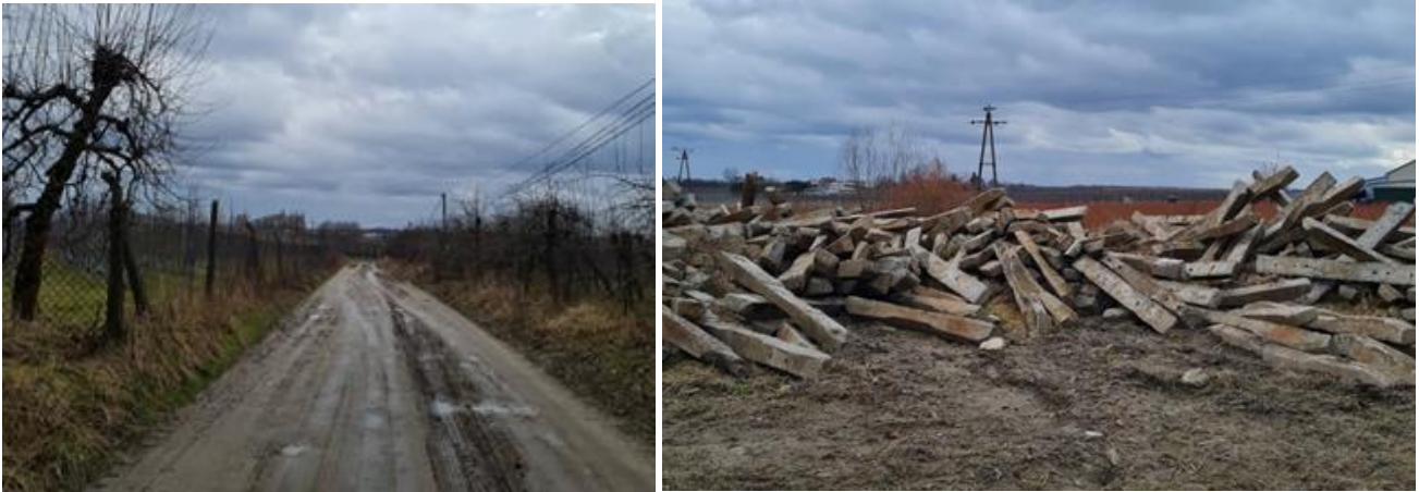
Zdjęcie 10 Wybrana droga gminna w Łęczeszycach oraz odpady po robotach budowlanych składowane przy drodze gminnej
